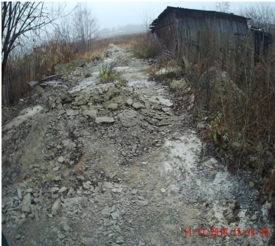
Перекрытие поверхности почвы выгруженными на земельный участок остатками бетона
