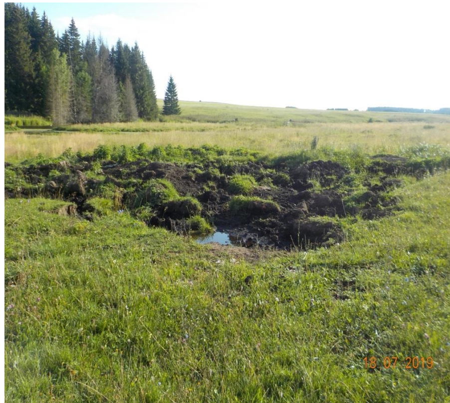
Снятие плодородного слоя почвы
